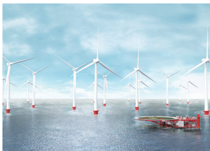
Energieinfrastruktur: Zeitersparnis und Effizienzsteigerung sowie verlängerte Wartungsintervalle bei schwer zugänglichen Befestigungspunkten.
