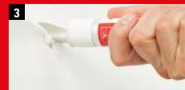
Spachtelmasse an gewünschte Stelle drücken, dabei das Bohrloch etwas überfüllen.
