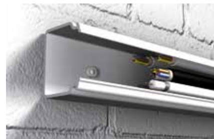
Incollaggio e sigillatura di profili metallici
