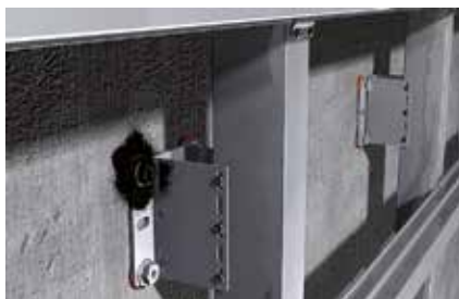
Sigillatura della testa delle viti
