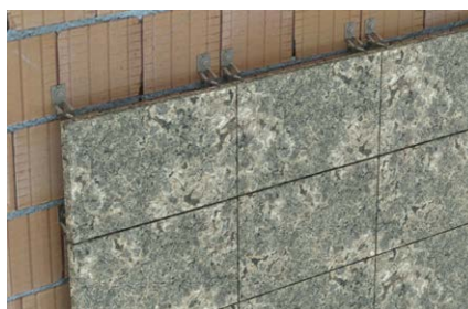
Rivestimento ventilato con fissaggio puntuale
