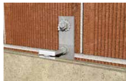
Dettaglio: fissaggio puntuale della lastra
