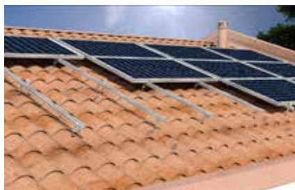
Struttura speciale su copertura a falda
