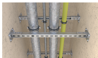
Horizontale Rohrtrasse: PSF
