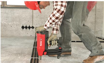
Zur Befestigung von elektrischen Verbindungen, z. B. Leitungen, Rohren und elektrischen Kabeln – an Boden, Wand oder Decke
