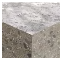
Calcestruzzo non fessurato
