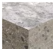
Calcestruzzo non fessurato
