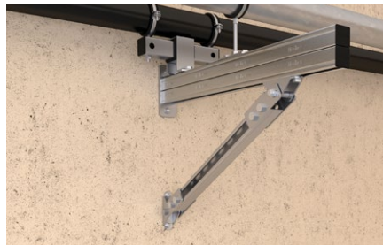
Costruzione di controventi.
