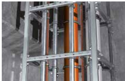
Strutture a telaio 3D
