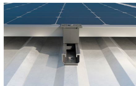
Copertura con rivestimento in lamiera grecata.
