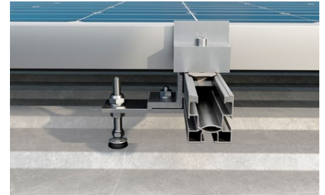
Copertura con rivestimento in lamiera grecata.
