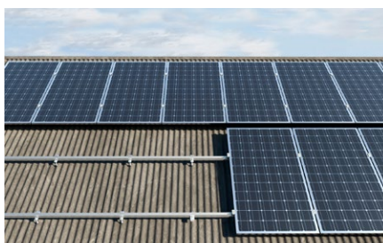
Copertura inclinata con rivestimento in lastre ondulate.
