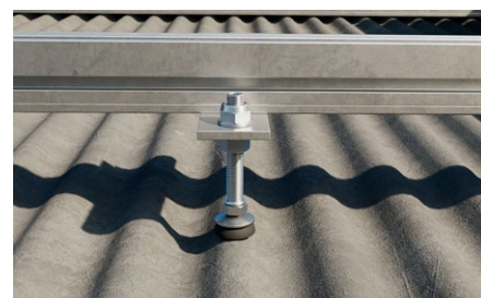
Copertura inclinata con rivestimento in lastre ondulate di laterocemento.
