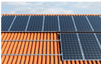
Copertura inclinata con rivestimento in tegole.
