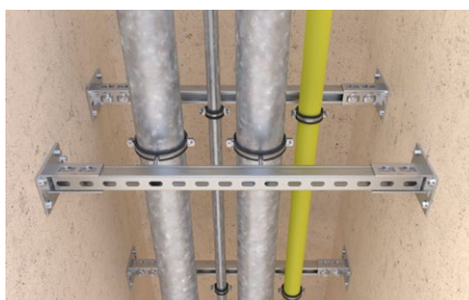
Installazione tubazioni su via di fuga.
