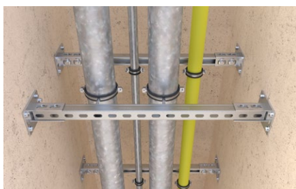
Installazione tubazioni su via di fuga.
