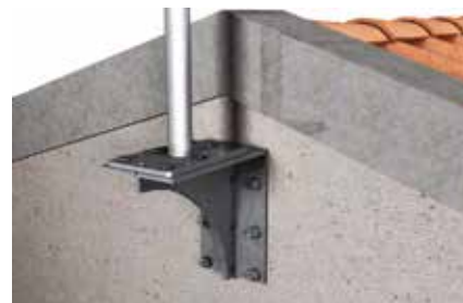
Dettaglio: fissaggio palo di estremità
