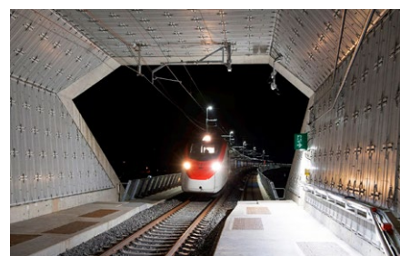
Sistemi di ancoraggio con isolamento elettrico.
