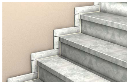
Fissare rivestimenti e battiscopa.
