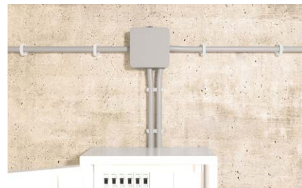
Fissaggio tubi in PVC.
