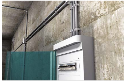
Fissaggio tubi in PVC
