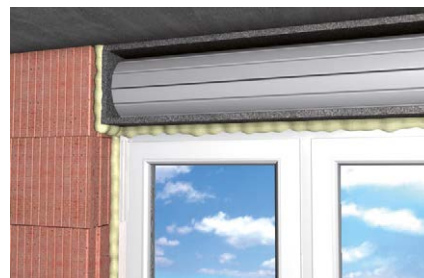
Giunti di connessione intorno ai cassonetti
