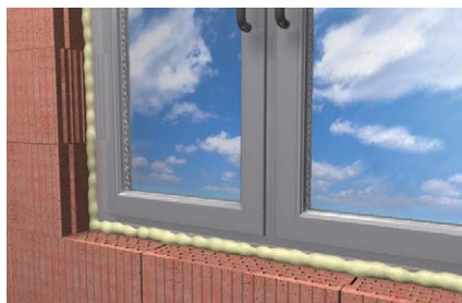
Giunti di connessione di serramenti
