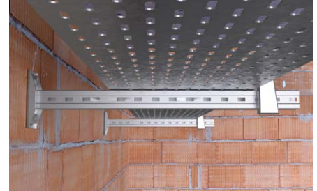
Staffaggio di impianti elettrici.
