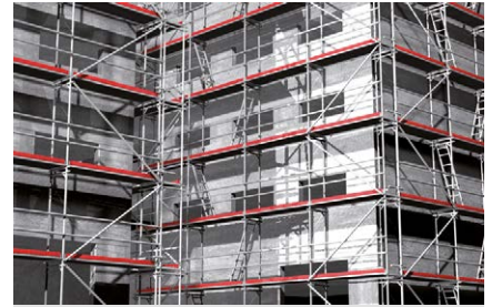
Ponteggio per facciata
