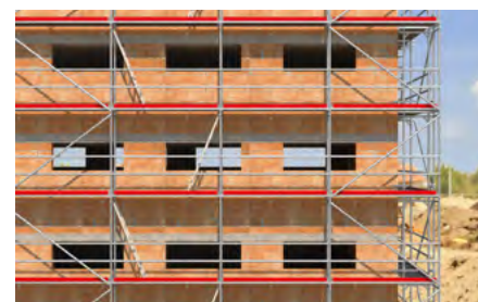
Ponteggio per facciata.
