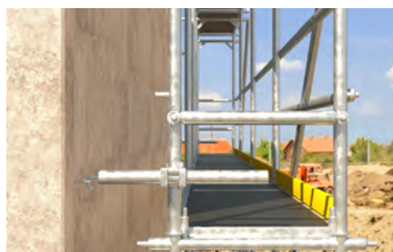
Fissaggio al ponteggio.
