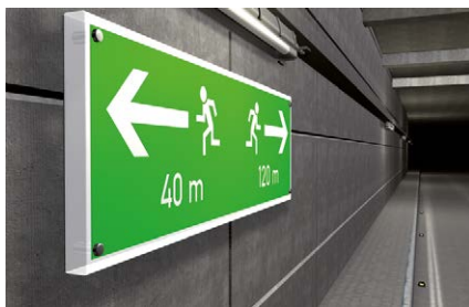
Segnali di uscita di emergenza in galleria
