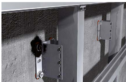
Sigillatura della testa delle viti
