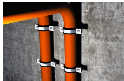
Fissaggio delle condotte in plastica
