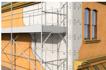
Fissaggio di pannelli isolanti
