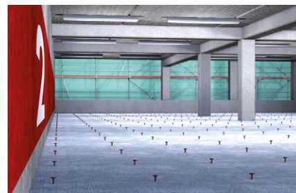
Rinforzo di solai
