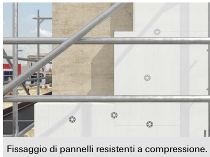
Fissaggio di pannelli di isolamento a cappotto.
