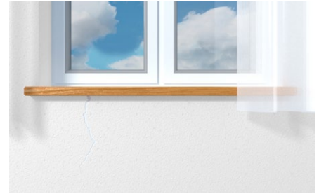
Fessure sulla parete.
