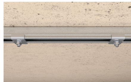
Installazione binario di montaggio a muro.
