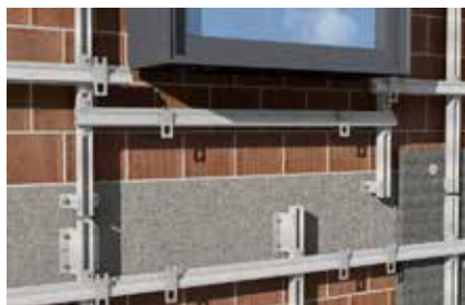
Sottostruttura montanti e traversi
