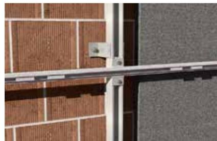
Dettaglio: collegamento al montante
