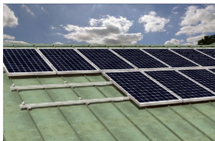
Impianto con moduli fotovoltaici con cornice
