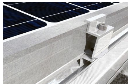
Dettaglio: fissaggio del modulo fotovoltaico
