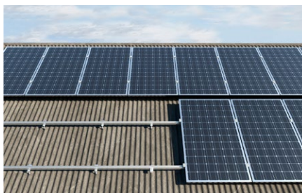
Copertura inclinata con rivestimento in lastre ondulate.
