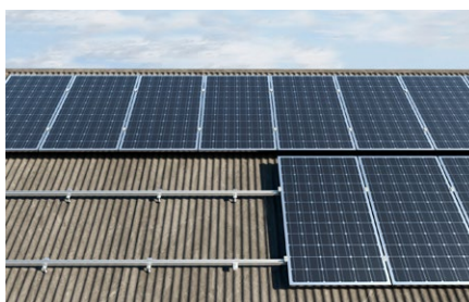
Copertura inclinata con rivestimento in lastre ondulate.
