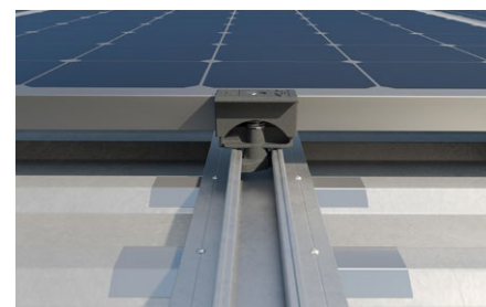
Copertura con rivestimento in lamiera grecata.
