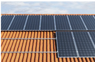
Copertura inclinata con rivestimento in tegole
