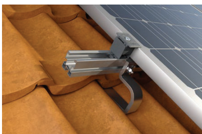
Copertura inclinata con rivestimento in coppi
