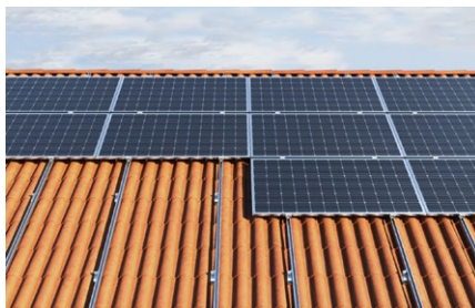
Copertura inclinata in tegole e pannelli con orientamento orizzontale
