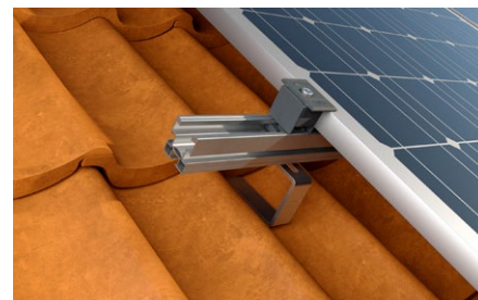
Copertura inclinata con rivestimento in tegole.
