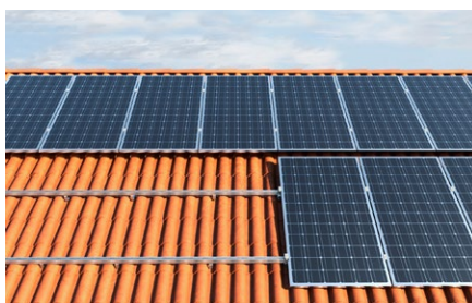
Copertura inclinata con rivestimento in tegole.
