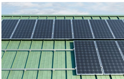
Copertura inclinata con rivestimento in lamiera aggraffata (aggraffatura piatta).
