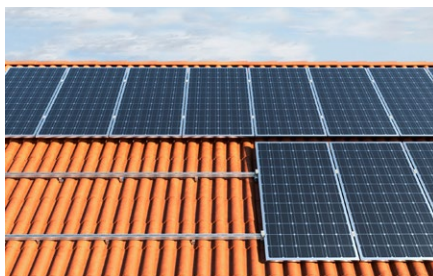
Copertura inclinata con rivestimento in coppi.
