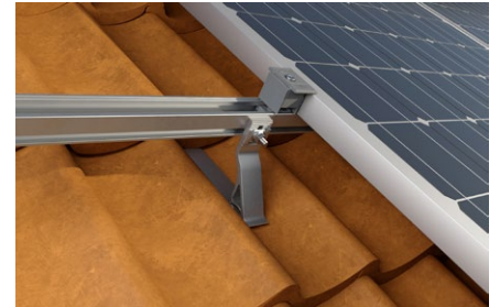
Copertura inclinata con rivestimento in coppi
