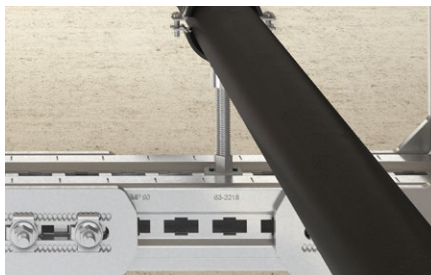
Collegamento collare su profilo FMP.
