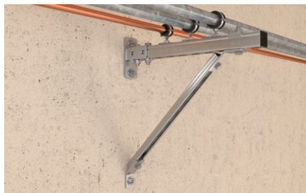
Installazione di tubazioni su strutture in profili FUS.
